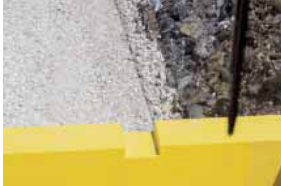
Compactación precisa en los bordes con el asistente óptico de carril.
