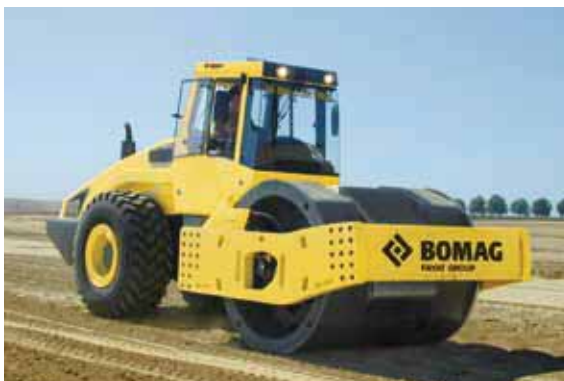
Un BW 226 DI-4 BVC durante la postcompactación del terreno existente.
