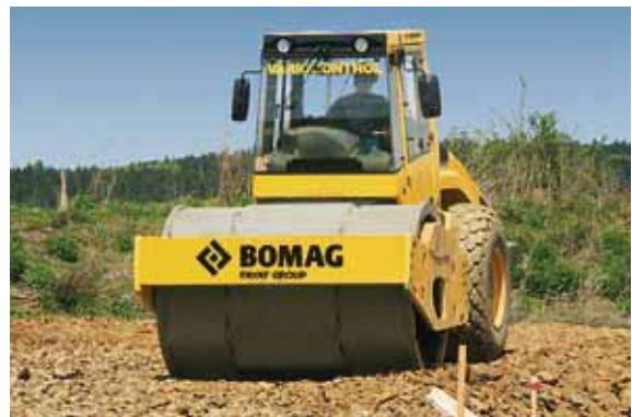
Compactación de material basto como base de una calzada.
