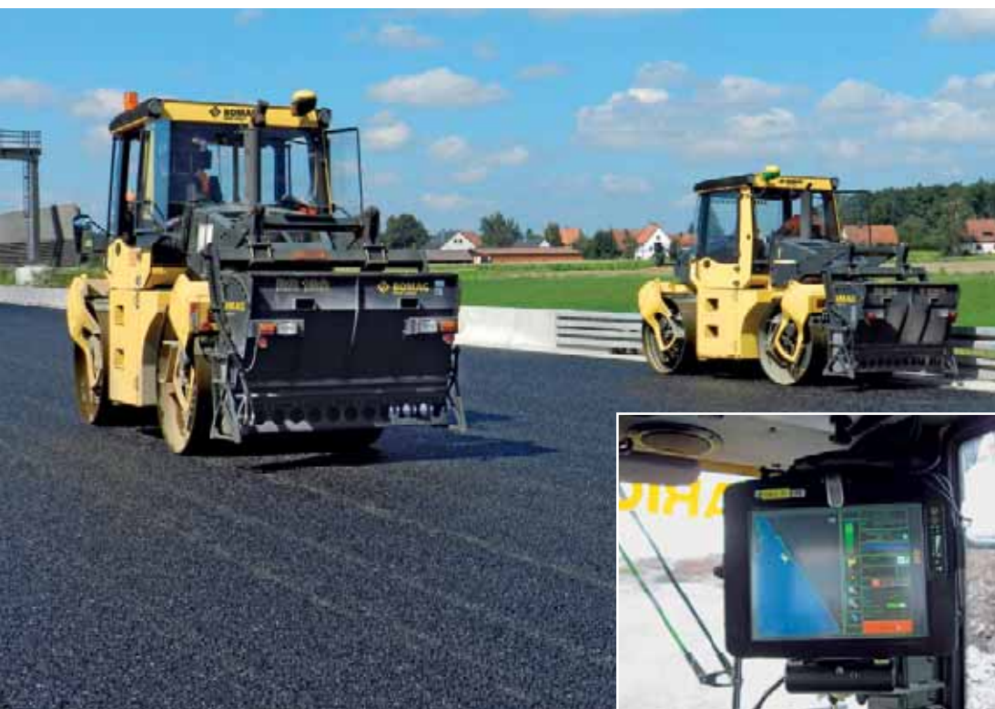
„BCM 05 mobile“ y el software de análisis de BOMAG „BCM 05 office“ permiten documentar una obra en toda su superficie.
