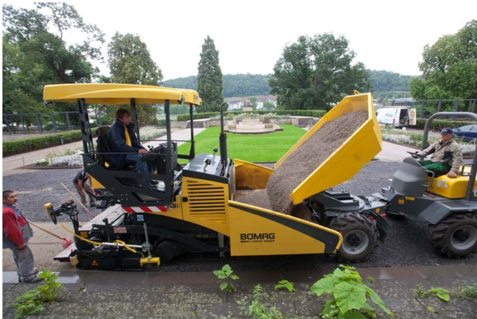
Precisión milimétrica con nivelación de ultrasonidos simple y sin contacto
