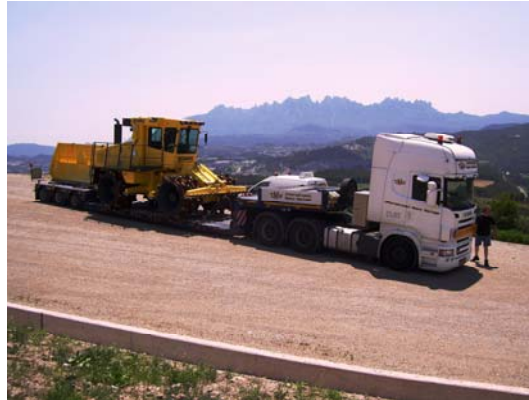
Llegada del transportista con la máquina con en el fondo las escarpías de la preciosa Sierra de Montserrat
